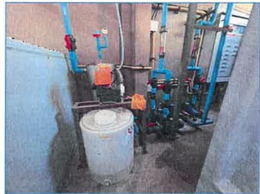
ชุดเติมคลอรีนเพื่อบำบัดน้ำทิ้งไปใช้รีไซเคิล
