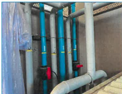
ท่อรวบรวมน้ำเสียเข้าสู่ระบบบำบัดน้ำเสียรวม
